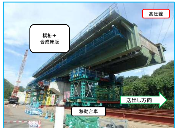
縦送り架設の状況
