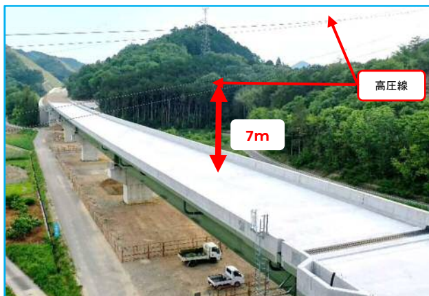
全景(令和元年5月時点)
