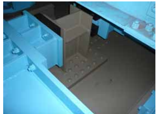
図-5 制震ストッパーの現地設置状況
