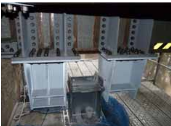
写真-6 制震ストッパーの設置状況(三本松橋)
