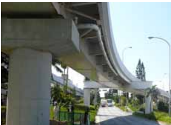
写真-2 山下垣花高架橋
