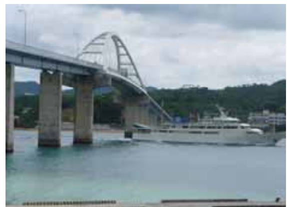
写真-7 瀬底大橋
