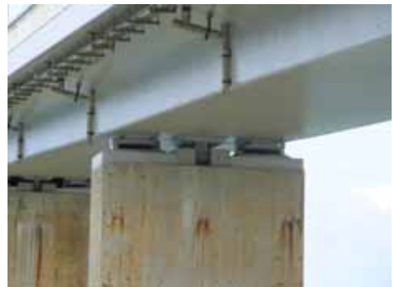
写真-8 制震ストッパーの設置状況(瀬底大橋)
