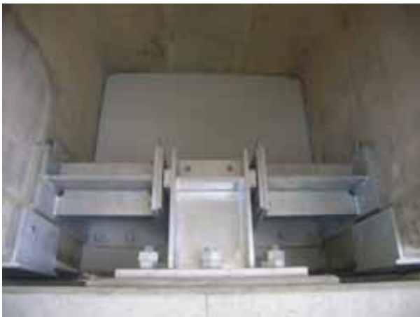
写真-10 制震ストッパーの設置状況(慶佐次大橋)
