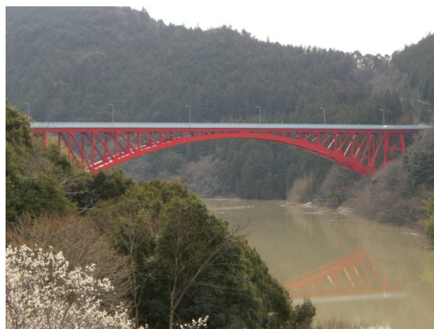
写真-5 橋梁全景(施工後)
