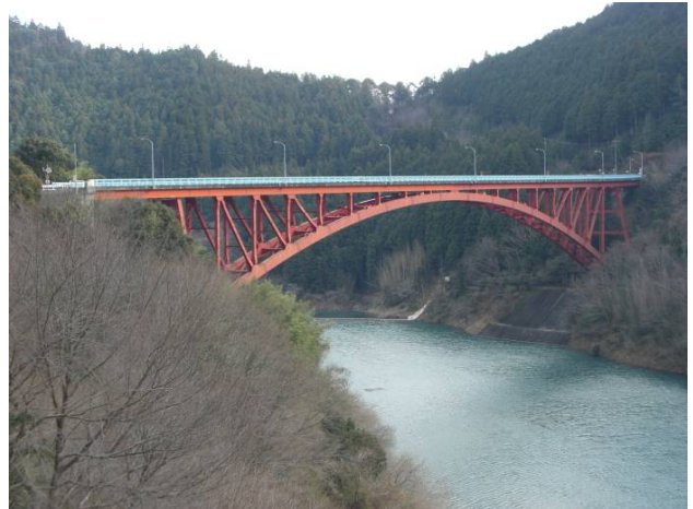
写真-1 橋梁全景（施行前）
