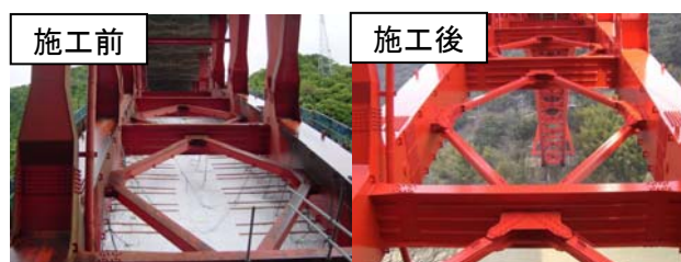
写真-3 下横構 SBBR 施工前後
