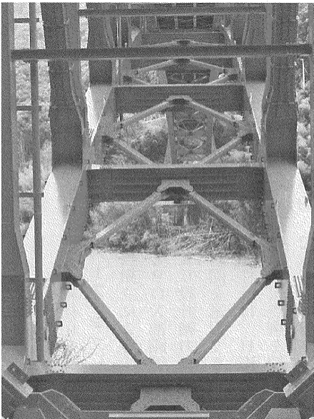
下横構への適用事例
