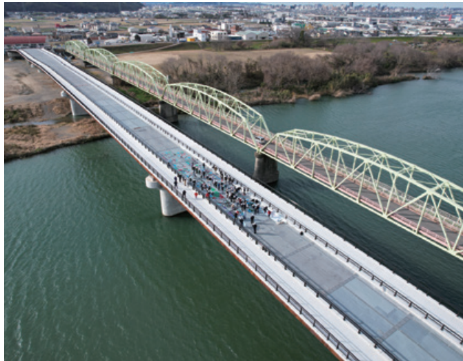
新南田井ノ瀬橋(和歌山県)現場見学会
