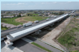
上蛇高架橋その2
