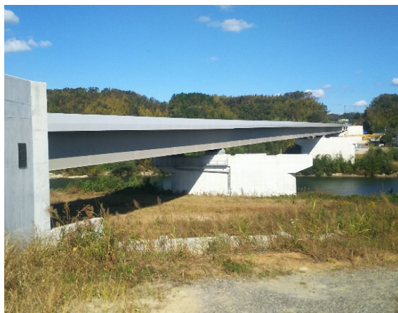
②平成28年度 153号豊田北BP矢作川橋西鋼上部工事
