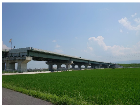
①平成27年度 東海環状口ヶ島南高架橋鋼上部工事
