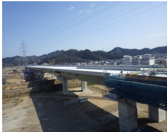
③平成28年度 東海環状鳥羽川高架橋鋼上部工事
