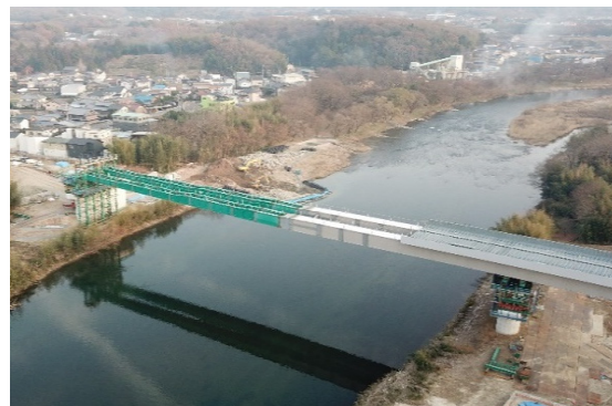
送出し架設状況
