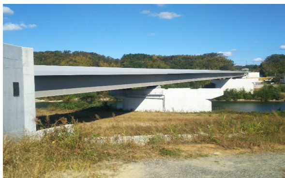
矢作川橋全景
