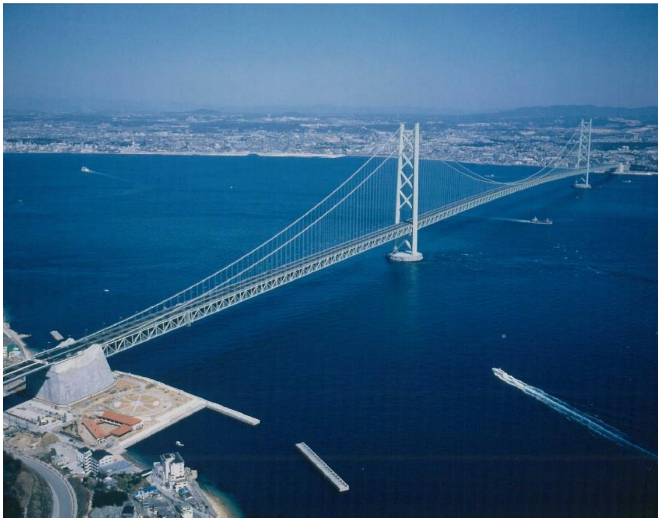
図表1-6. 明石海峡大橋(1998年3月竣工、同年4月供用)
