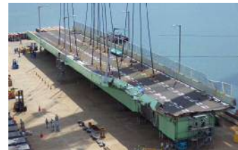
関西空港連絡橋復旧工事
