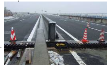
仙台東部道路復旧工事
