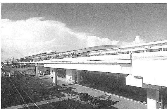
那霸空港高架道路上部工工事
