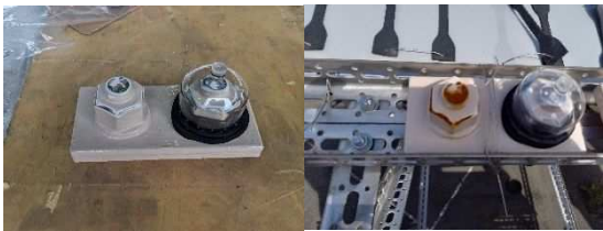
(a)試験開始時 (b)1年経過時 図-4 ケース1の暴露状況
