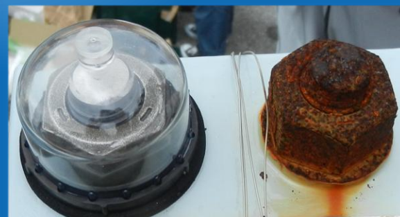
無塗装ボルトにキャップを設置
