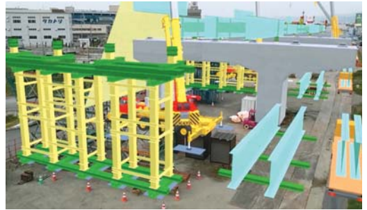
荷取りや地組立、架設時の作業スペース確認
