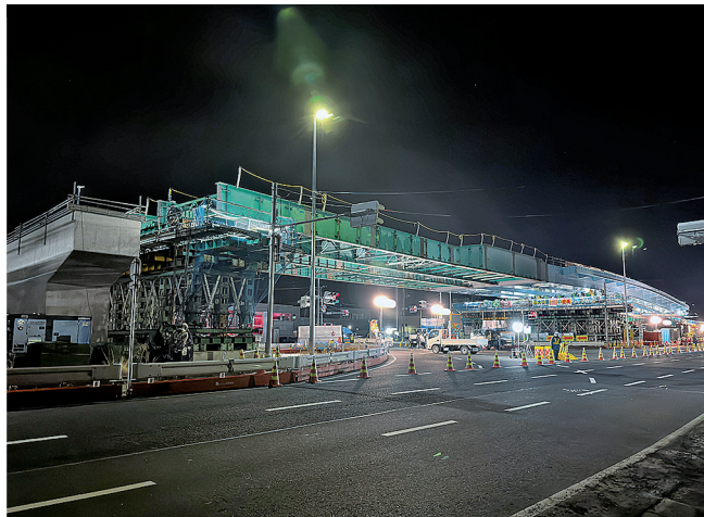
交差点直上に送り出す鋼桁（2日夜撮影）
