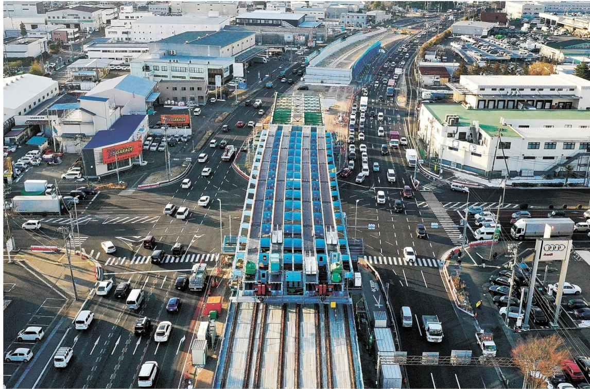
⑤箱堤交差点で一夜にして架けられた橋桁は3日午前4時45分ごろ、仙台市内の朝の渋滞が始まった箱堤交差点。中央の青い部分が一晩で架けられた4車線分の橋桁。北から南を望む。3日午前7時30分ごろ、仙台市内
